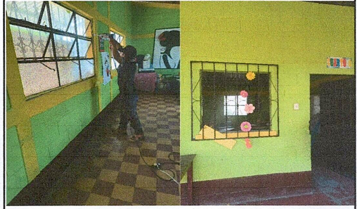
Foto 2: Mejoramiento de ventanas para una mejor ventilación e iluminación.
