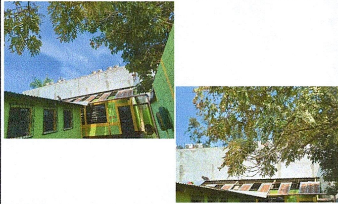
Foto 1: Mejoramiento de techo en modulo de salones de clases, bodega y cocina.
