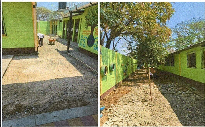
Foto 3: Mejoramiento de losa de patio.
